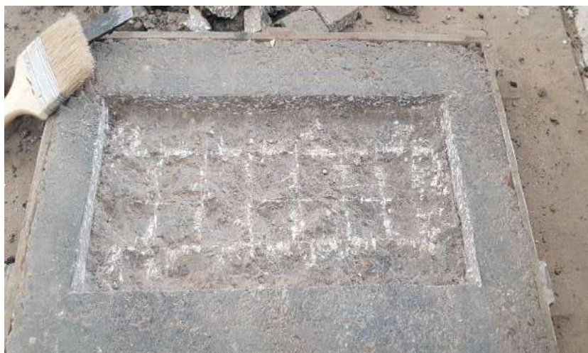
รูปที่ 2-54 จำลองสภาพความเสียหายหลุมบ่อ (Pot Hole) บนแผ่นแอสฟัลต์คอนกรีต
