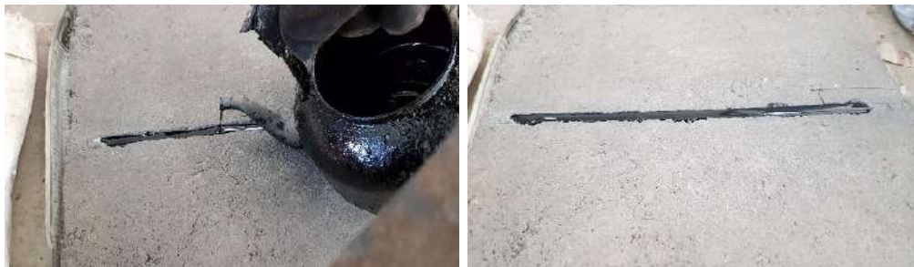
รูปที่ 2-60 ขั้นตอนการเทส่วนผสมวัสดุอุดซ่อมรอยแตก
